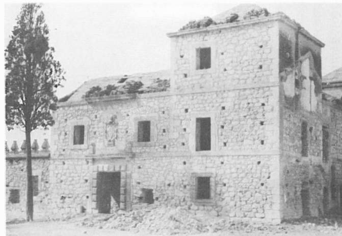
Fig. 6.- Fachada principal con la mampostería vista y las cubiertas en reconstrucción. (Tomada a finales de 1985)
