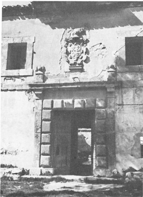
Fig. 5.- Detalle de las ventanas y puertas principales de piedra de cantería y labrada con el escudo de la familia Pérez de Aroxtegui en la parte superior
