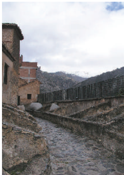
PATIO DE TROJES DE LA ALMAZARA DE NIGÜELAS
