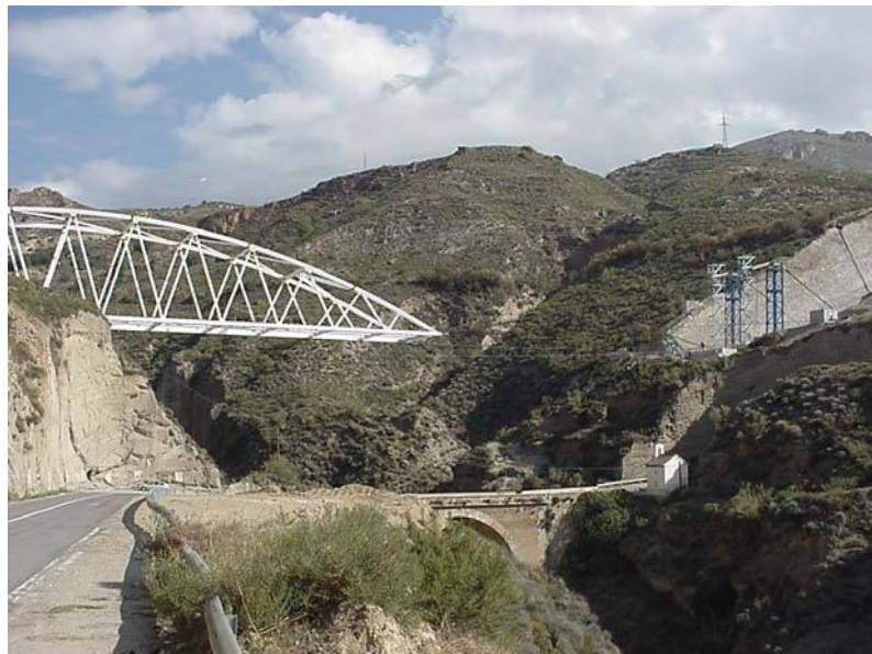
Figura 4. Empuje de la primera mitad del puente
