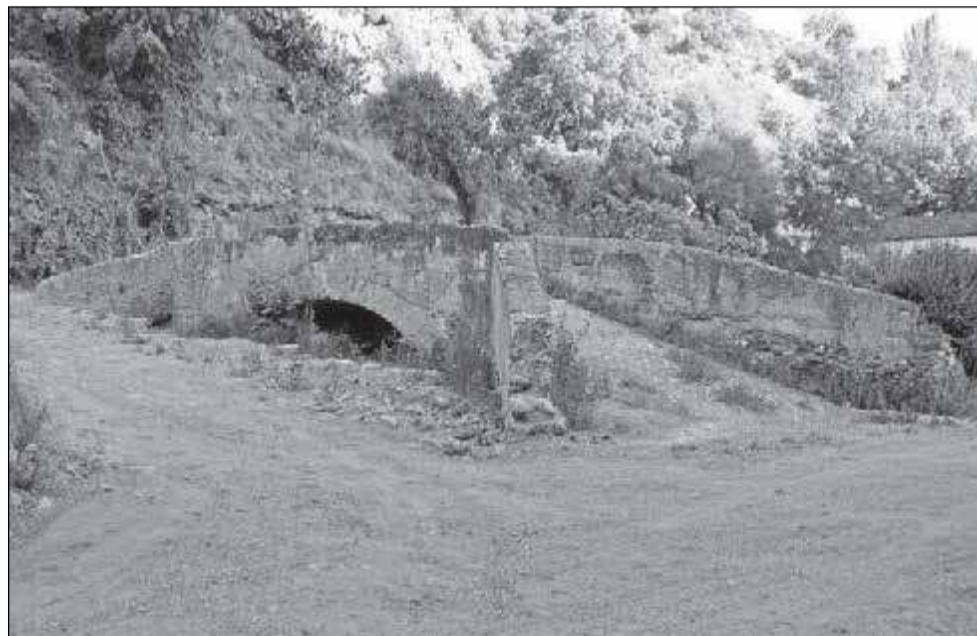
El Puente Medieval de Dúrcal.
