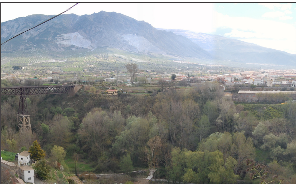
Fotografía. Vista general del núcleo de Dúrcal desde la cuesta de la Valdesa.
