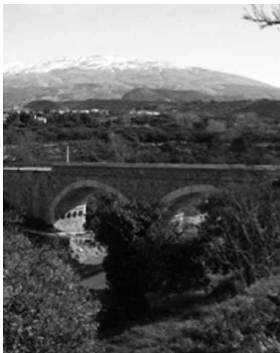
Puente que separa las localidades de Melegís y Restábal
