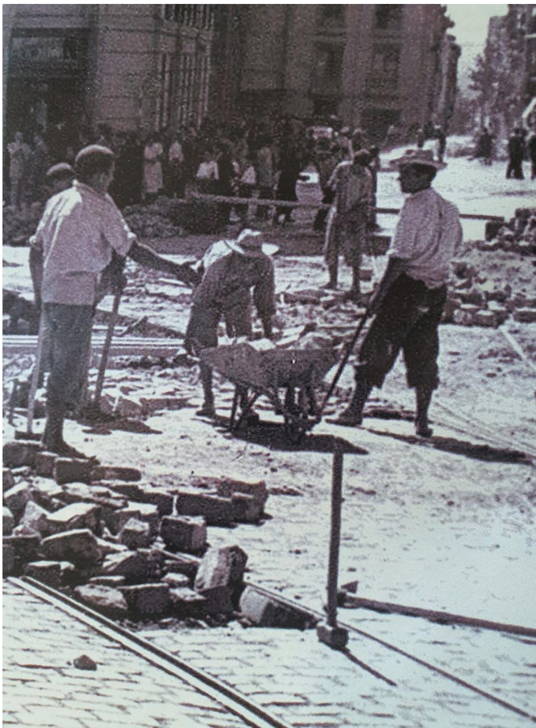
Obras de ensanche de Recogidas.
