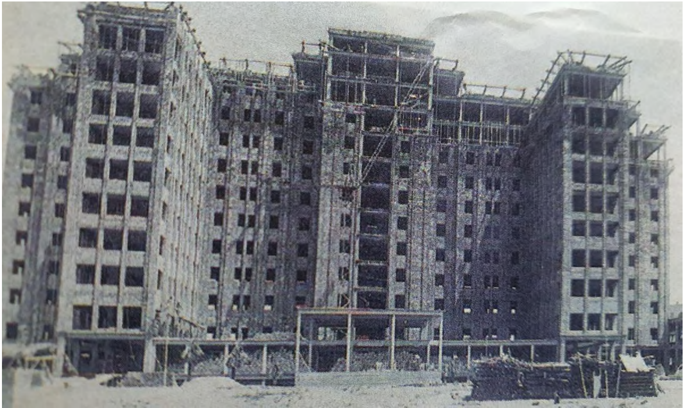
Se inicia la construcción del Hospital Ruiz de Alda.
