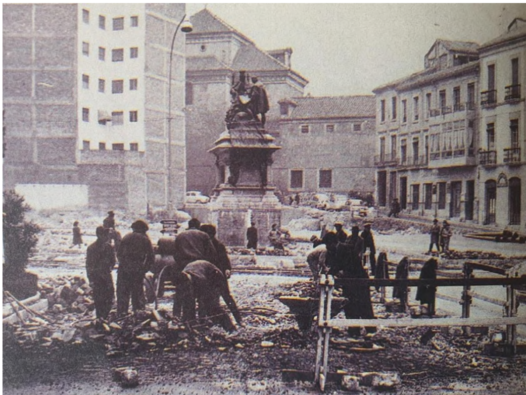
Obras en la Gran Vía.
