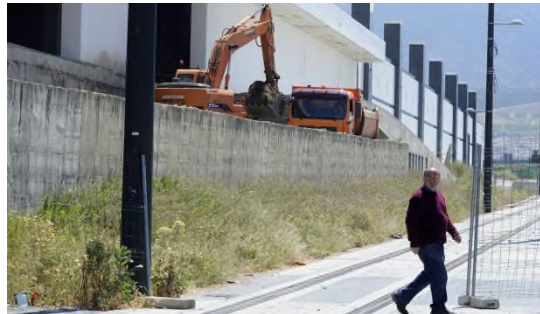
Inicio de los trabajos de demolición de 4. 046 metros cuadrados del edificio que albergaría el Centro Comercial Nevada / MIGUEL ÁNGEL MOLINA / EFE
