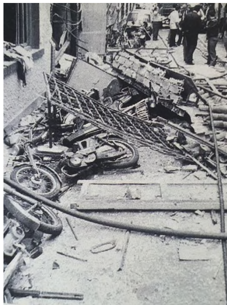
Destrozos producidos por la explosión en la calle Elvira / G. A. A.
