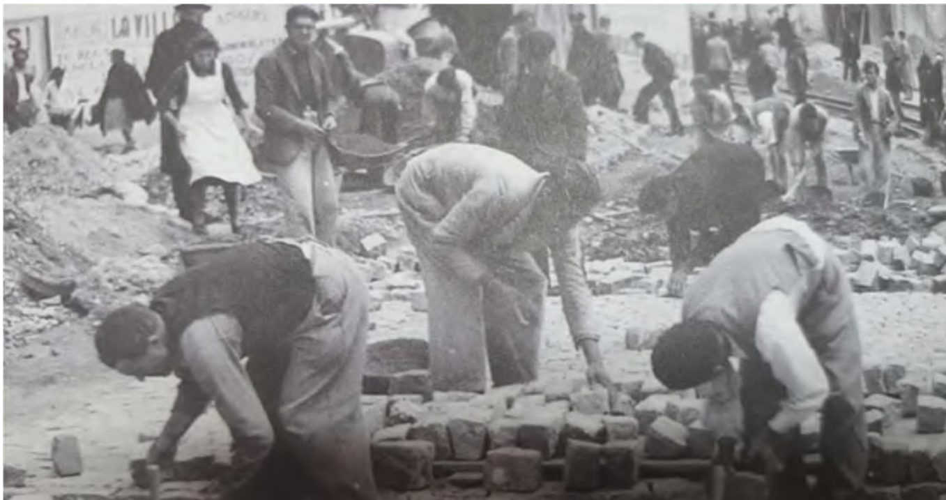
Empedrado en la calle Ganivet
