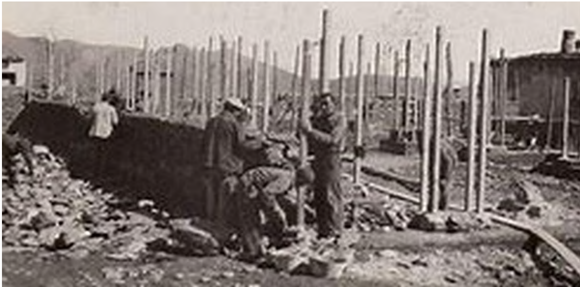
Obras de reconstrucción en Pitres.
