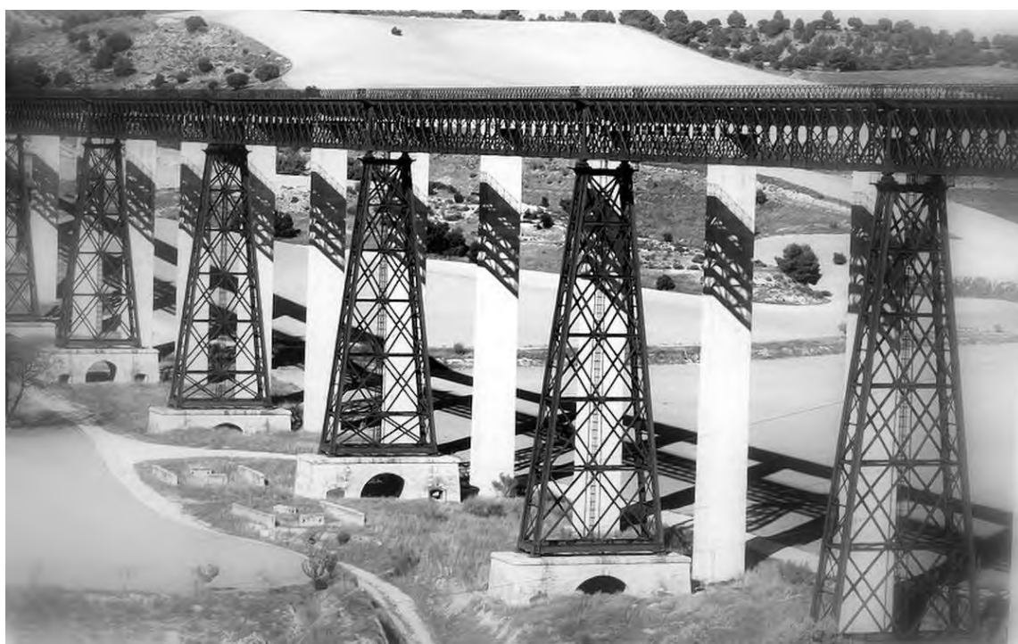
Viaducto del Hacho.
