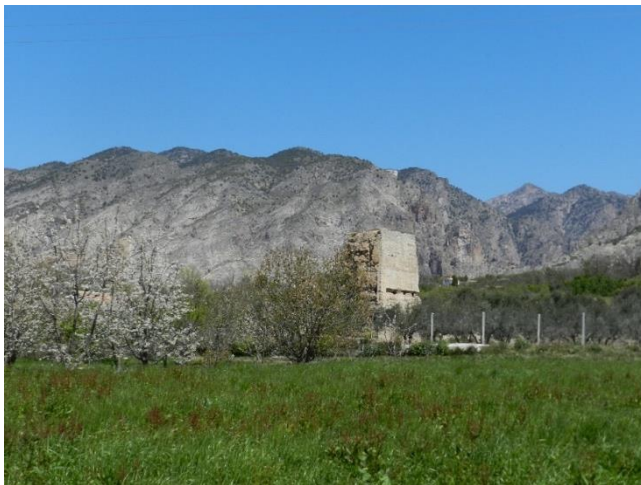
Figura 6: Fotografía de la esquina suroeste de la torre, 2018. (Fotografía del autor).
