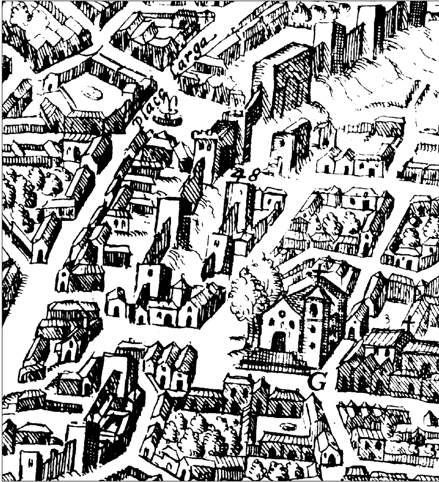
3. Detalle de la Plataforma de Granada. Dibujada por A. de Vico, grabada por Heylan. La Puerta de Heman Roman ni siquiera aparece indicada como elemento urbano destacable. Se conserva el lienzo y torres del primer recinto excavadas durante los años 80.
