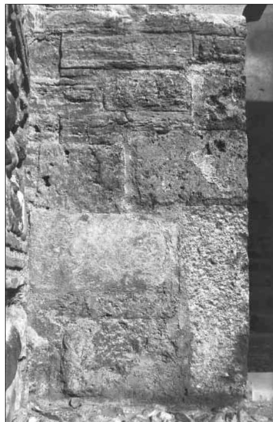
16. Puerta Monaita. Jamba con sillares romanos almohadillados.
