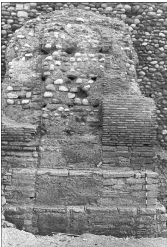
15. Portillo del León. Vista frontal después de la excavación.
