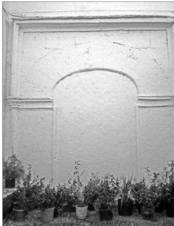
Estado actual de la portada lateral de la Iglesia de Restábal.
