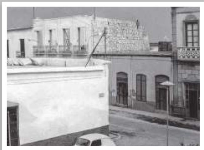
Vivienda de planta baja en el nº 7 de Natalio Rivas, propiedad de Rogelio Vargas Manzano. Allí estaba ubicada la Casa del Pueblo, en su parte posterior, con acceso al Paseo de los Tristes. Colección A. Aguilera París.
