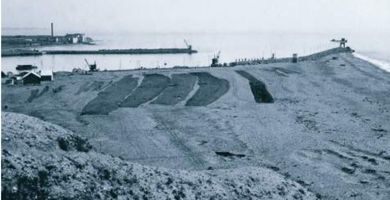
El puerto de Adra en construcción. Anónimo francés, enero de 1936. Colección Lorenzo Cara Barrionuevo.
