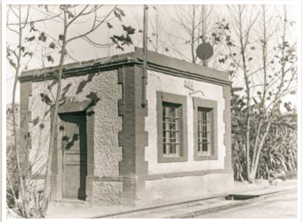
Foto 2: Caseta de la báscula de pesaje de vagones en la confluencia del camino de la cantera y la carretera de Almería, instalada en 1912. Colección Domingo Fernández. Inventario JOP diciembre 1934. Caja 1. N.º 43.
