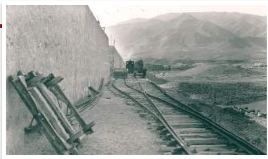
La locomotora Koppel en el andén del dique de Poniente. Fotografía realizada el 22 de julio de 1953. Colección Narciso Espinar Campra. Obsérvese a la derecha de la imagen la gran barrera de arena que había cerrado al completo la bocana del puerto a finales de marzo de ese año.
